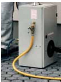
Sicherheitsabschaltung Quick-stop safety device
